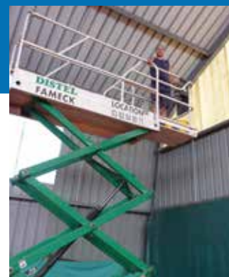
Des travaux à 7 mètres de hauteur
