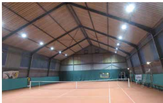
Le nouvel éclairage LED du court couvert
