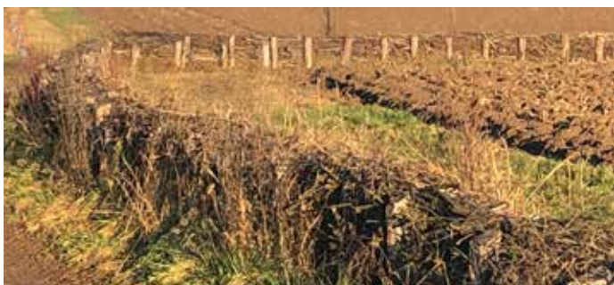
Fascines mortes vers Kutzenhausen
